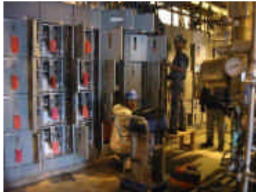
Mantenimiento CCM sala de Bombas.
