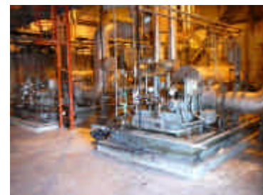
Corte piso drenajes en Sala de Bombas
