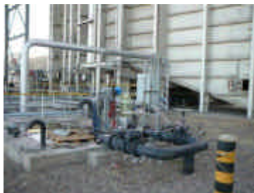
Cambio bomba de purgas
